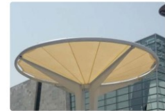
Ett våderskydd ger klimatekydd i väntan på bussen samtidigt som det skapar en mötesplats
